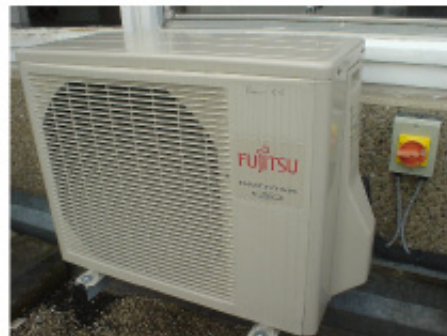
Figuur 13. Goed: Binnen- en buitengedeelte van een warmtepomp die warmte uit de lucht haalt met een prestatiecoëfficiënt van 4. Om de grootte aan te geven is tegelijk met het binnendeel een balpen gefotografeerd. Eén van deze units van Fujitsu kan 3,6 kW aan verwarming leveren bij een elektriciteitsverbruik van slechts 0,845 kW. Hij kan ook omgekeerd werken en levert dan 2,6 kW aan verkoeling voor 0,655 kW aan elektriciteit.
